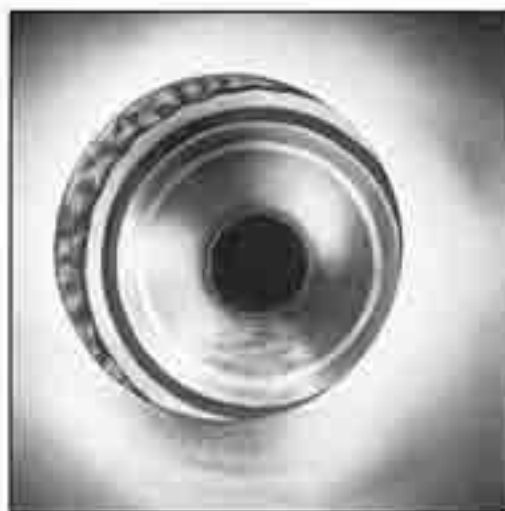
Radiell fogförskjutning på plaströr Grad 3.
