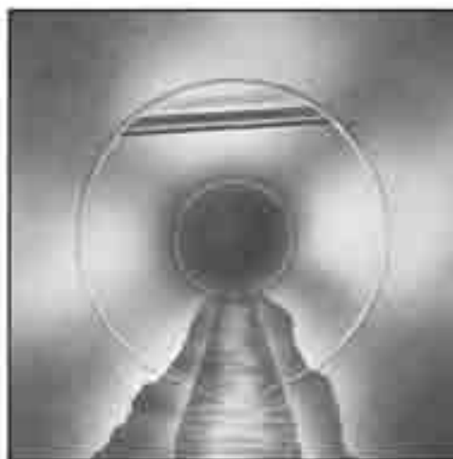
Synlig tättningsring i plaströr. Grad 1, grad 2 eller grad 3 beroende på rörets placering.
