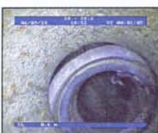
Längsförskjutning, öppen fog, grad 3
